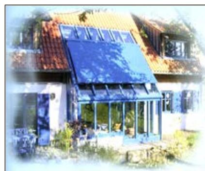
Neben intensiver Sonneneinstrahlung ist der Grad der vom Glas absorbierten Sonnenstrahlen, die Einbausituation und das Scheibenformat von Bedeutung.
